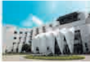
台南研發中心 (鑽石級綠建築)
